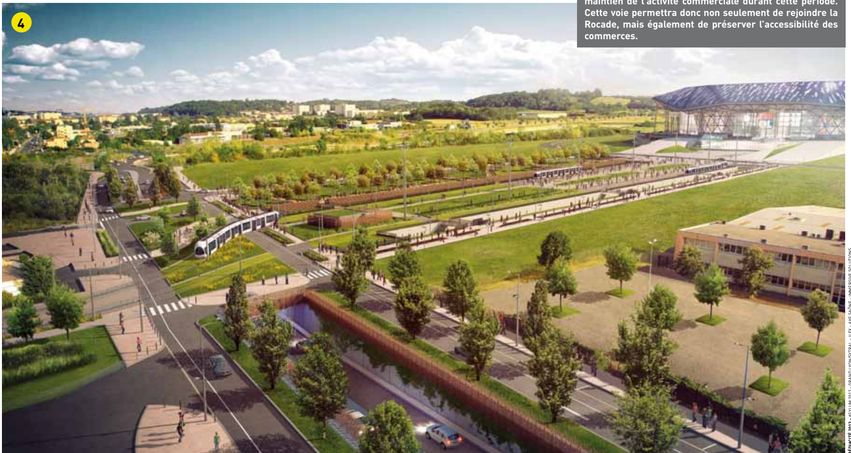
La future trémie sous l'avenue Jean-Jaurès
